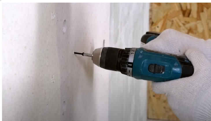
Рисунок 18. Стягивание между собой пазогребневых стыков саморезами по ГВЛ.
