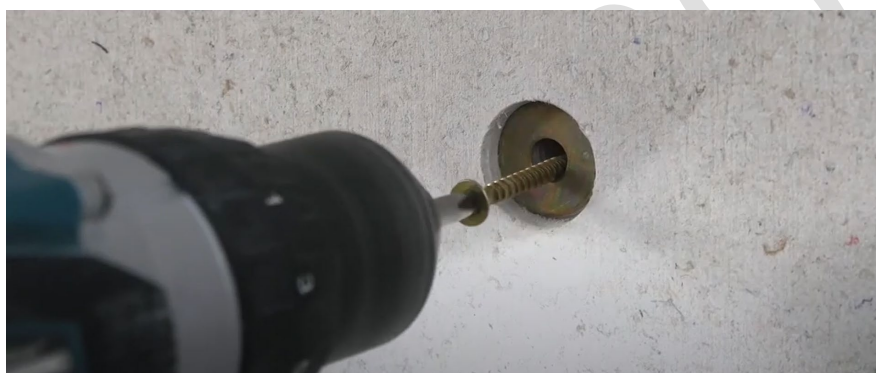
Рисунок 17. Схема закрепления панелей к стенам из полнотелых гипсовых блоков.
