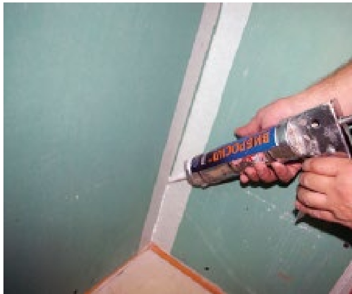
Рисунок 21. Заполнение швов герметиком Вибросил.
