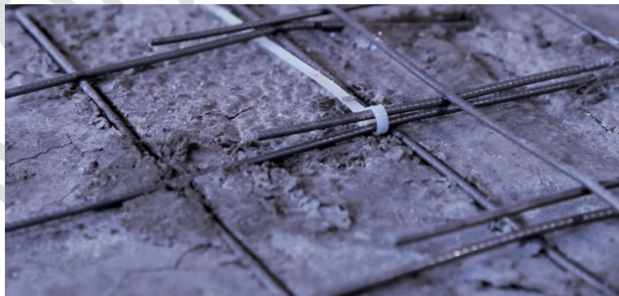
Рисунок 12. Перевязка металлической сетки.
