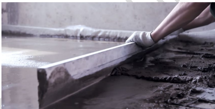
Рисунок 19. Выравнивание поверхности раствора.
