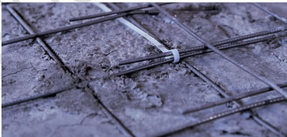
Рисунок 17. Перевязка металлической сетки.
