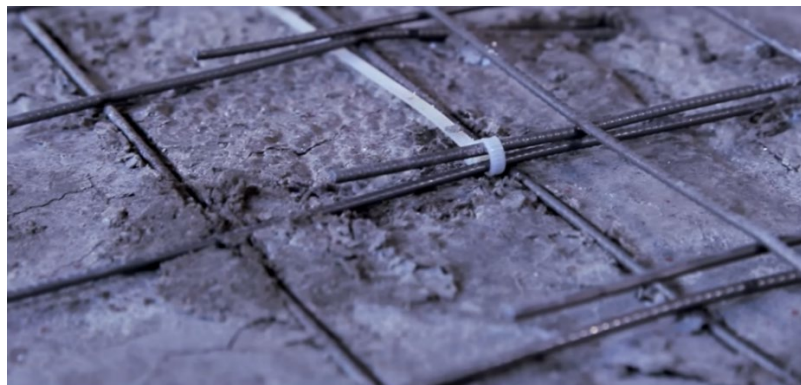
Рисунок 19. Перевязка металлической сетки.
