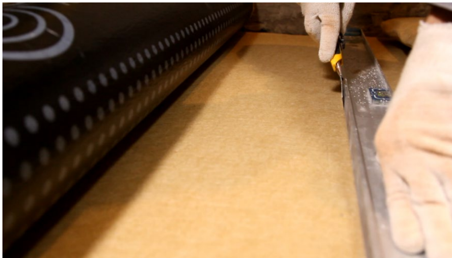
Рисунок 7. Обрезка материала строительным ножом.
