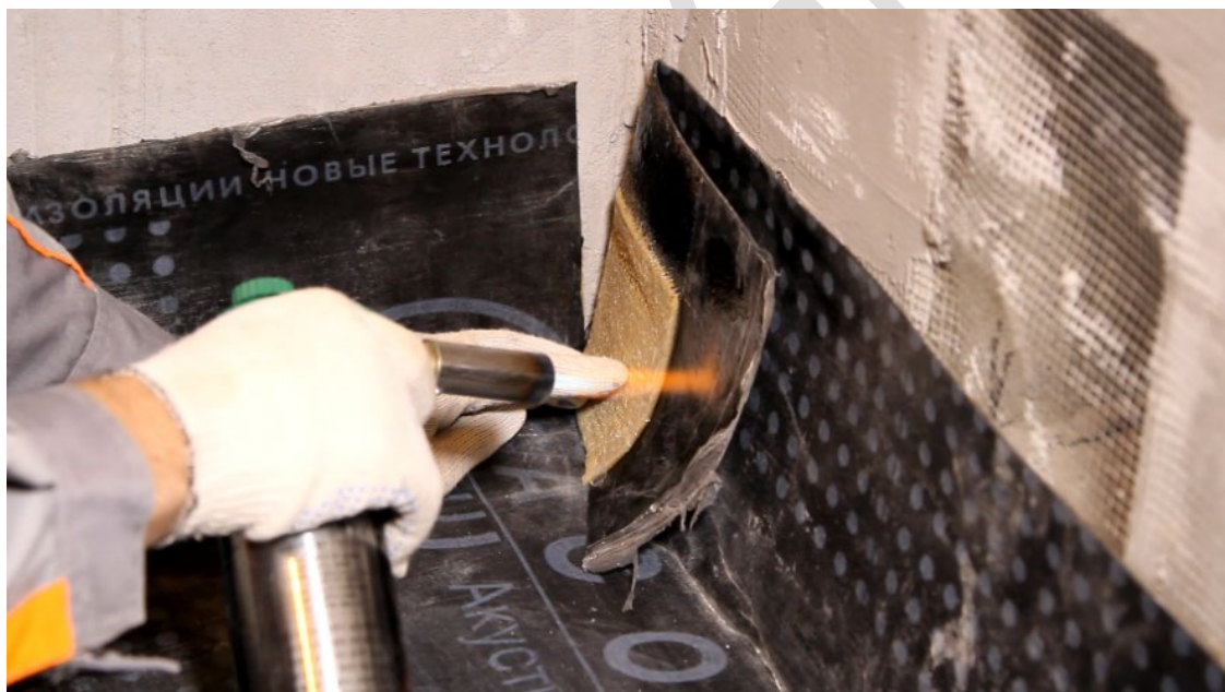
Рисунок 10. Приваривание лепестка материала к кромке при помощи газовой горелки.
