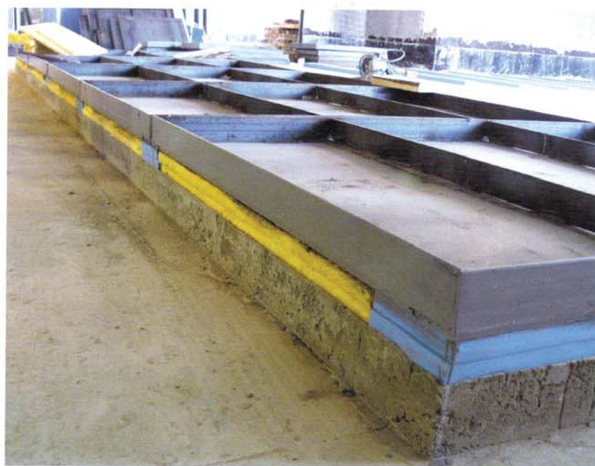
Устройство виброизолирующего фундамента на материале Sylomer
