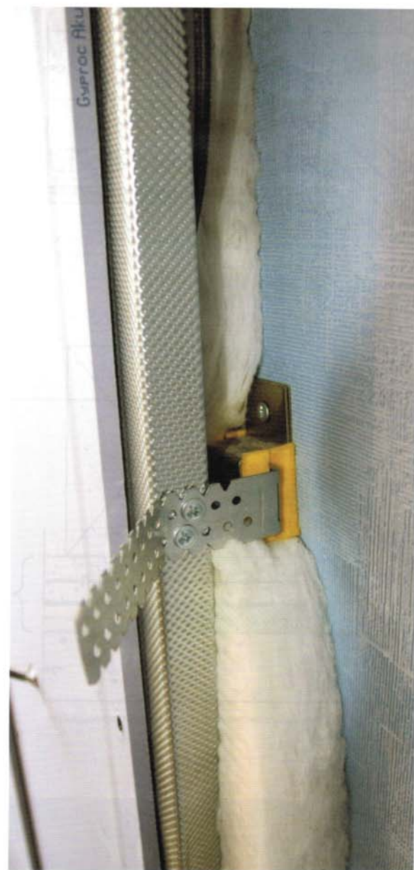
Монтаж звукоизоляционной облицовки
