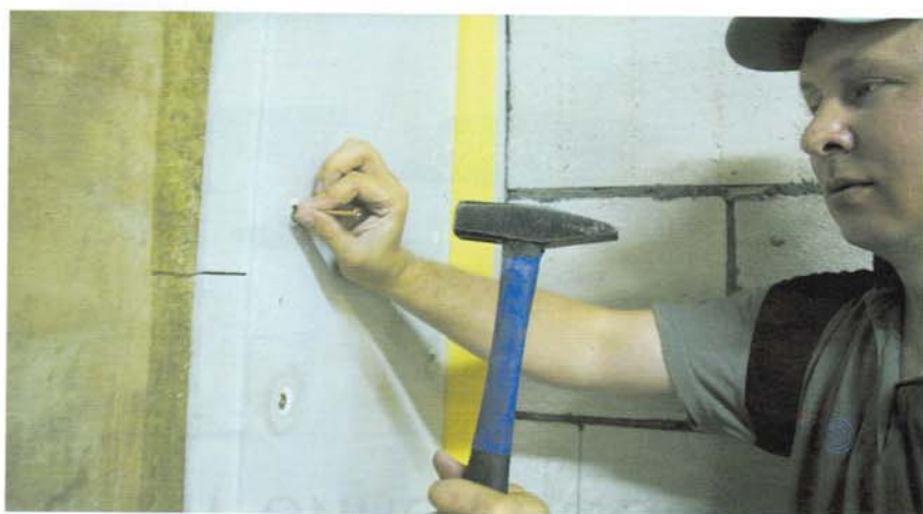
Монтаж звукоизолирующей панельной системы ЗИПС
