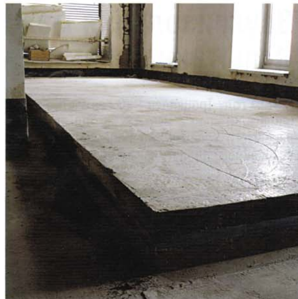
Готовый виброизолирующий фундамент с материалом Sylomer
