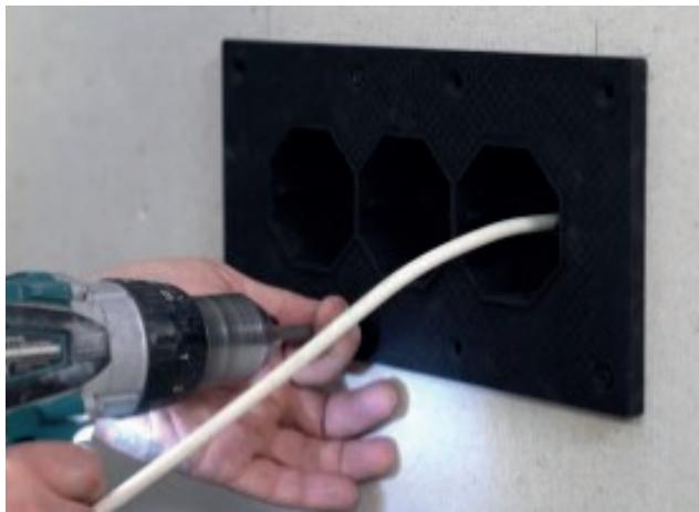
После установки подрозетника место вывода провода герметизируется при помощи герметика Ультракустик или Вибrosил.
