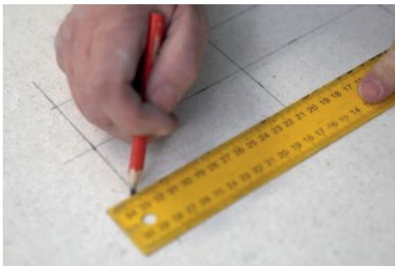
На первом слое обшивки или сэндвич-панелях ЗИПС требуется выполнить разметку и при помощи электролобзика или ручной пилы вырезать отверстие под установку подрозетника УЛЬТРАКУСТИК.
