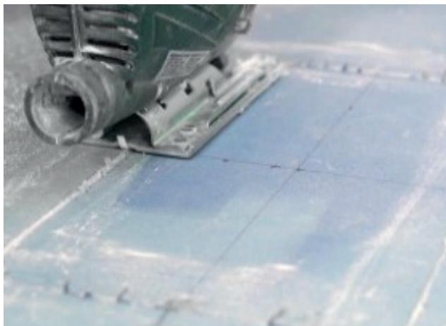
В финишном слое обшивки также необходимо вырезать отверстие под размер внешней части подрозетника.
