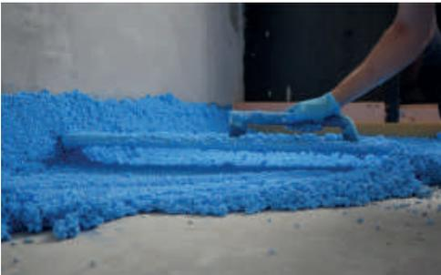
После обработки периметра помещения смесь Шумопласт высыпается на перекрытие. Для получения прочной и эффективно работающей структуры материал в обязательном порядке уплотняется полутёрком до толщины, примерно равной 20 мм.
