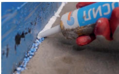
После набора прочности стяжки излишки кромоочного слоя обрезаются строительным ножом. Полученный шов заполняется герметиком Вибросил.
