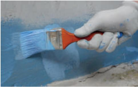
На стены и колонны по периметру помещения кистью или валиком необходимо нанести слой грунтовки Шумопласт-грунт на 30-40 см выше, чем уровень выравнивающей стяжки.
