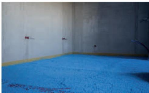
Через 48 часов при температуре не ниже 15°C смесь толщиной 20 мм полностью полимеризуется, после чего необходимо уложить разделяющий слой из армированной полиэтиленовой пленки толщиной 200 мкм, также с заведением краев на все стены и колонны.
