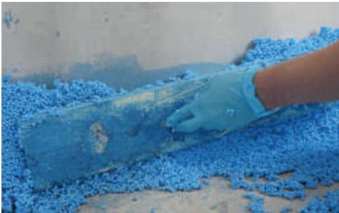
Затем смесь Шумопласт при помощи полиуретанового «полутерка» наносится толщиной примерно 20 мм на стены и колонны, обработанные грунтом.
