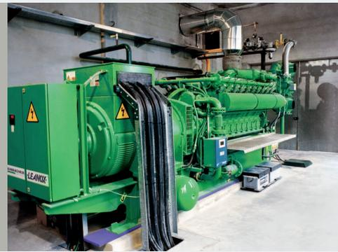
Установка машинного оборудования на упругих виброизоляционных опорах при особых требованиях к пожаробезопасности
