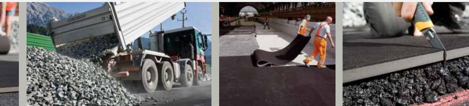
Если производится реконструкция эксплуатируемых участков с применением матов, то основание, на которое укладывают маты, часто состоит из старого щебеночного балласта. В этом случае хорошо себя зарекомендовал метод устройства с обеих сторон мата слоя, распределяющего нагрузки.
