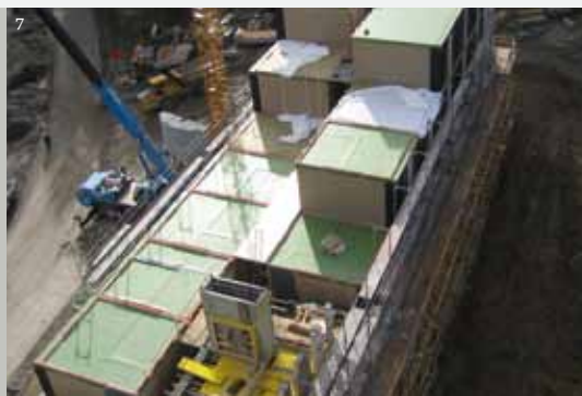
Деревянные модули с опорами из материала Sylomer®
