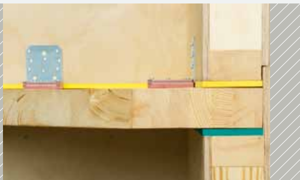
Упругая опора стены и перекрытия
