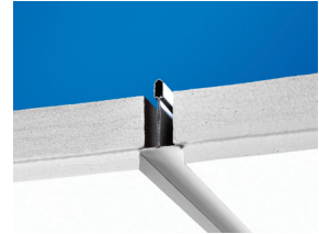
Фрагмент системы Master E
